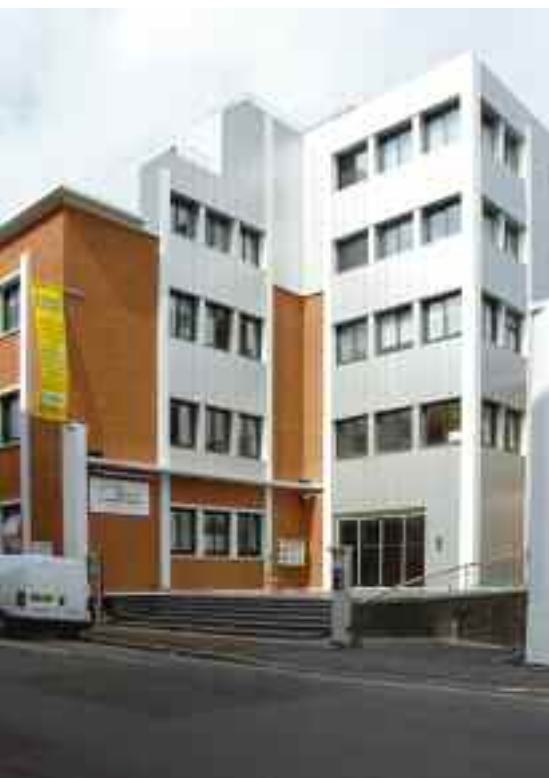
Exemple de transformation de locaux, rue Avaulée.
